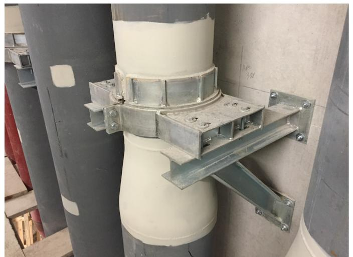
Point fixe froid pour colonne montante dans un centre de calcul
