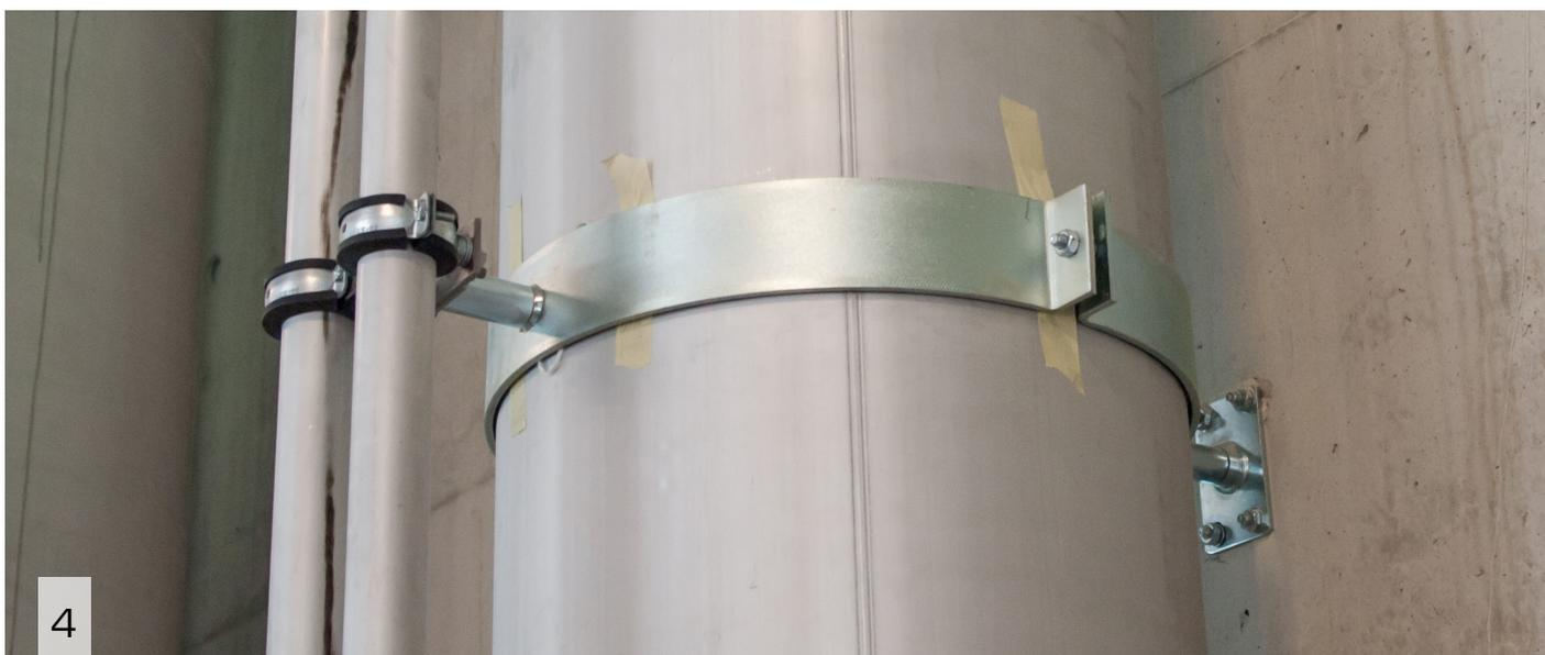
1. Point fixe froid et chaud 2. Suspension libre renforcée 3. Bride de fixation sur IPE avec Lindapter 4. Collier double
