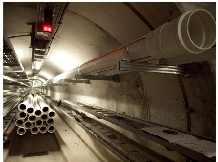
Ligne de courant fort triphasé 400 kV, 800 A dans une galerie technique.
